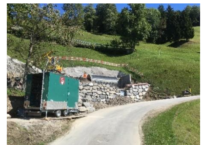
Hinter der Bruchsteinmauer die beiden Tanks, schön eingebettet im bestehenden Gelände.
