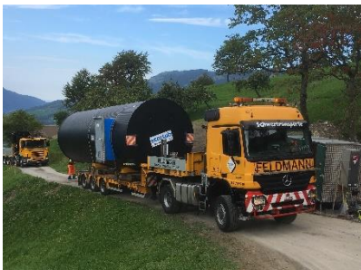
Das Wasserreservoir und die Brunnenstube werden mittels Schwertransport angeliefert.
