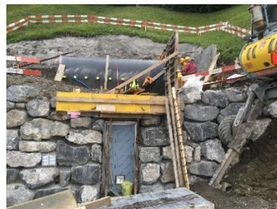
Verkleidung des Reservoirs mit einer Bruchsteinmauer sowie Schalen und Betonieren eines Vordaches für den Einstieg in das Reservoir und in die Brunnenstube.
