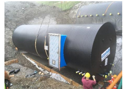
Versetzen des Reservoirs auf ein vorbereitetes Sand-Kiesbett.
