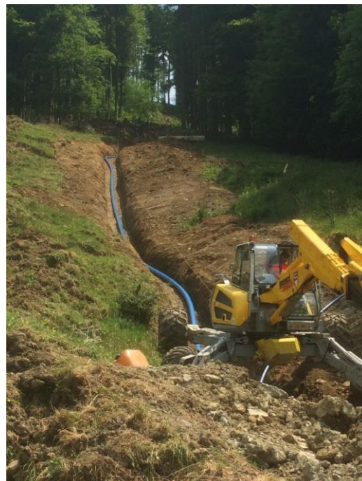
In steilem Gelände wird im Gebiet Schwand die Zubringerleitung verlegt.
