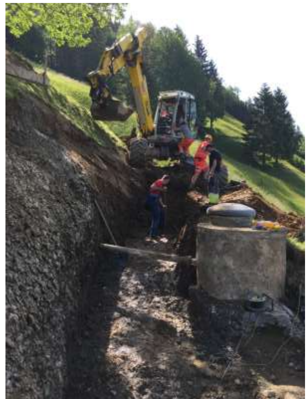
Der Muck ist aufgefahren und hat den Graben für die Leitungen bereit. Bei der Quelle Q5 sieht man den Fassungsstrang, welcher in die Fassung führt.
