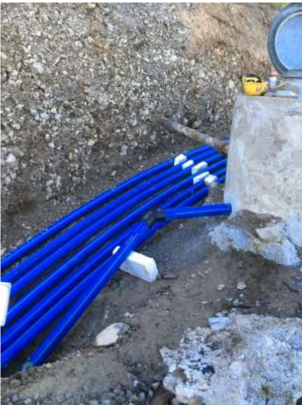
Die verschiedenen verstärkten Rohre (blaue Ummantelung) sind bereits verlegt. Die Quelle Q5 ist mittels Kernbohrung neu angeschossen worden.
