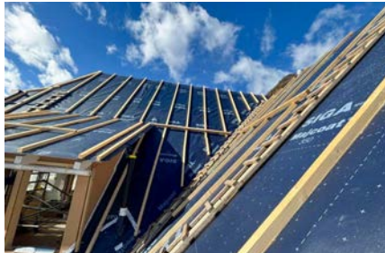
In luftiger Höhe wurde die Arbeit als Zimmermann erlebt.
